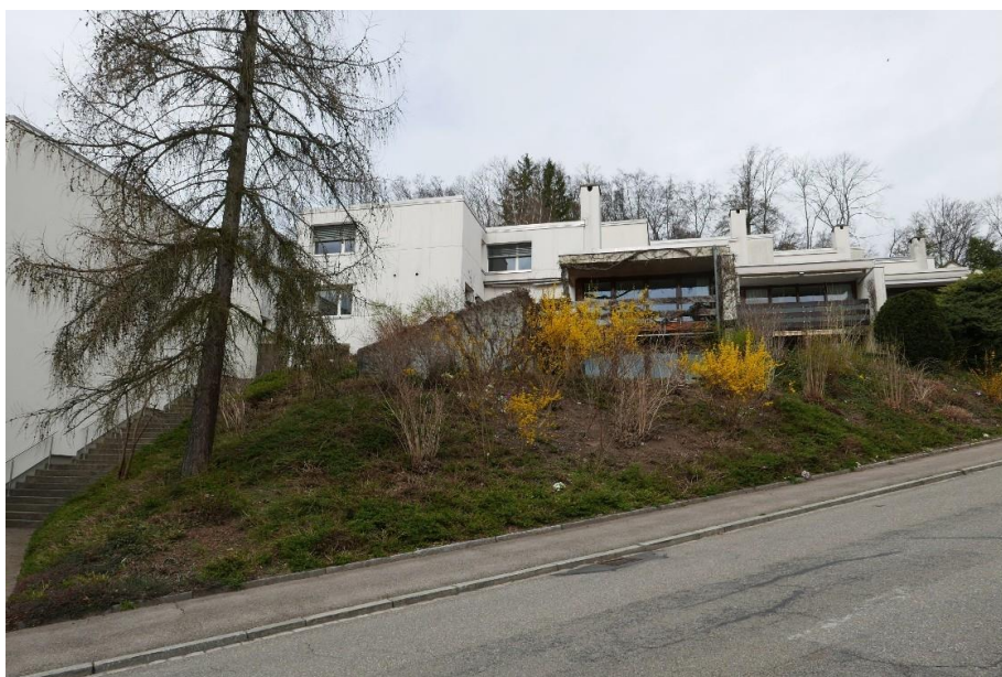
Siedlung «Haselsteig», Typ A / Reihe 2, Ansicht von S, 21.03.2017 (Bild Nr. D101351_34).
