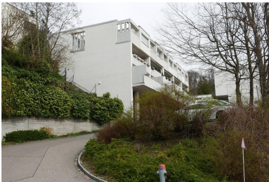
Siedlung «Haselsteig», Typ B / Reihe 3, Ansicht von SW, 21.03.2017 (Bild Nr. D101351_39).
