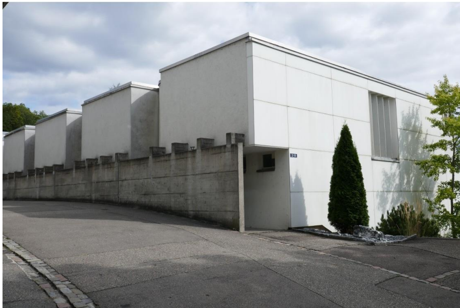
Siedlung «Haselsteig», Typ B / Reihe 4, Laubengang, Ansicht von NW, 21.08.2019 (Bild Nr. D101351_35).
